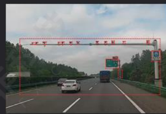
公路路产自动化巡检
